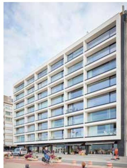
Une nouvelle façade en béton préfabriqué contribue à un rafraîchissement architectural de la digue de Knokke et ajoute également 50 ans à la durée de vie de 'Le Globe'.
